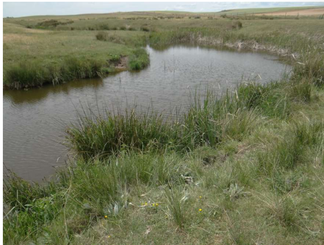
Área crítica nº 17 - Río Mazores (Cantalapiedra, Salamanca)
